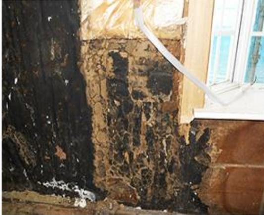
木造住宅の外壁の中は、室内からの湿気が入り込んだり、あるいは断熱材の欠損があると**壁内結露（内部結露）**を起こす可能性が高いとされています。事実、今までの軸組工法や2 X 4工法でも寒冷地を中心として、壁内の湿気による結露やカビが発生する事故が過去に多く報告されています。この壁体内結露は、結露によって壁内の木材が腐って建物の耐久性を低下させたり、表面的には室内側の石膏ボードの裏面からカビが発生し、室内環境そのものも不衛生な状態となっていきます。
