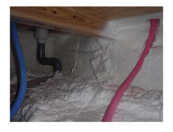
実際に私の自宅の天井裏・床下を覗いて見ましたが、見る限りでは構造体への損傷はなく、もちろんアイシネンへの損傷も全く見られませんでした。なぜ今回の大地震でもアイシネンが耐えられたかというと、圧倒的な柔軟性と密着性にあると思います。今回の様な地震で柔軟性がないパネル系断熱材、硬質フォームはおそらくクラックが入ったり接着面の剥離等が起こり気密レベルの低下が懸念されます。また吹込み系断熱材や繊維系断熱材もこの度重なる余震で沈下している可能性も大いにあると思います。
