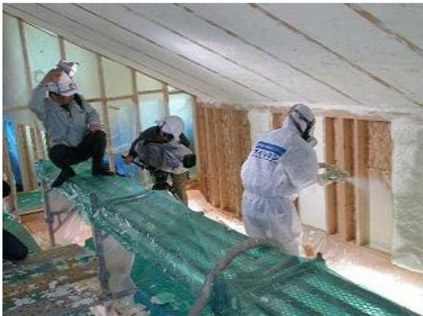
今から8年前の2008年7月の洞爺湖サミット開催前に北海道でネット・ゼロ・エネルギーハウスが建てられました、地域区分がIという事もあり、屋根断熱にアイシネンを300ミリ厚で吹き付け、壁は外張りと壁充填のアイシネンの組み合わせで対応されたそうで、実験的な試みが今や現実となり、これから標準仕様とやらなければなりません、IV～V地区の熊本でさえ、屋根を180ミリ、壁を86ミリ以上で吹き付ける必要があります、高性能設備も含めて設計段階から十分な計画が必要です。
