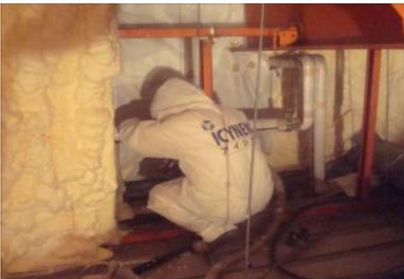
左写真のように、小屋裏の空間高さ 1100 以上ある場合は、小屋裏作業も可能です。そして今回のように浴室側と食堂側との小屋裏の仕切り部に仮に天井面から屋根面までシートを張りそのシートにアイシネンを吹き付けることで室内と同じ界壁が簡単にできます、これで小屋裏の温熱環境が室内と同等になり、浴室側からの熱や湿気の移動をシャットアウト。
