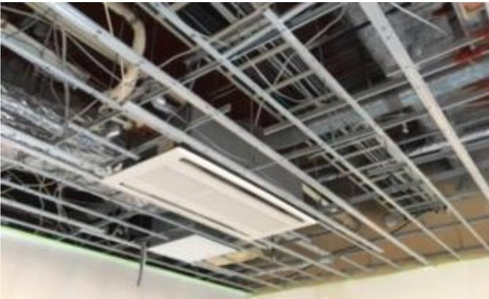
天井ボードのみの解体で軽天下地、空調ダクト等は残った状態での施工、このような非常に困難な現場状況が吹付断熱工事の一番の見せ所です。他の繊維系や成型物の断熱材では難しい工事ですが、その問題を難なくクリアして一番結果の出しやすい断熱材、それが発泡ウレタンです。また、冒頭に述べました「鉄部」にアイシネンを吹き付けることによって防サビ効果もあります。
